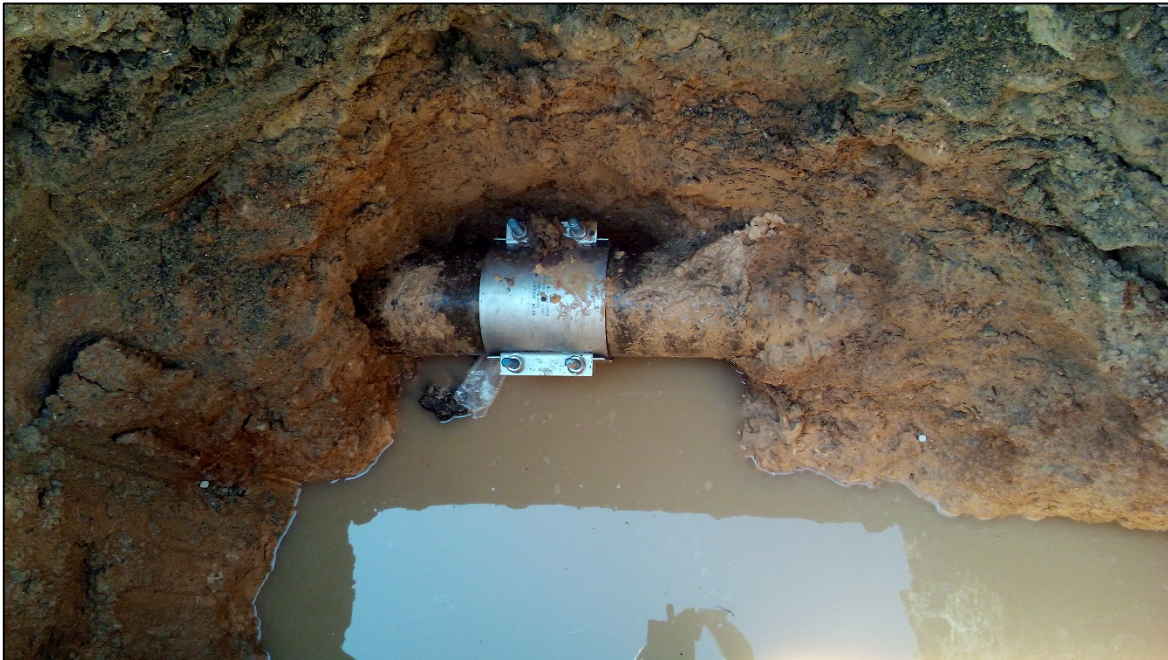
Εικόνα 7: Επιδιόρθωση διαρροής
