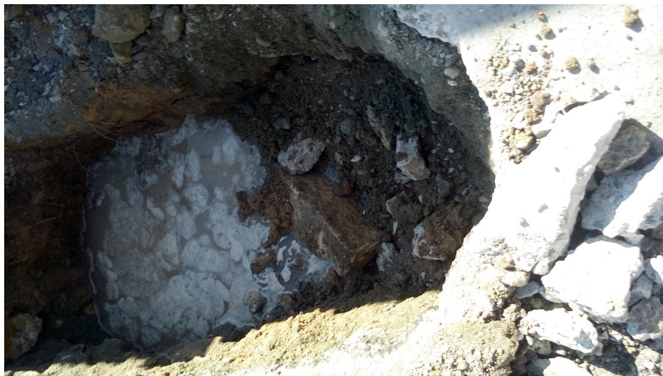
Εικόνα 5: Αποκατάσταση διαρροής νερού
